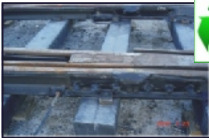
Axion Kompozitové pražce pod speciální konstrukcí Toronto TTC Streetcar Březen 2009
