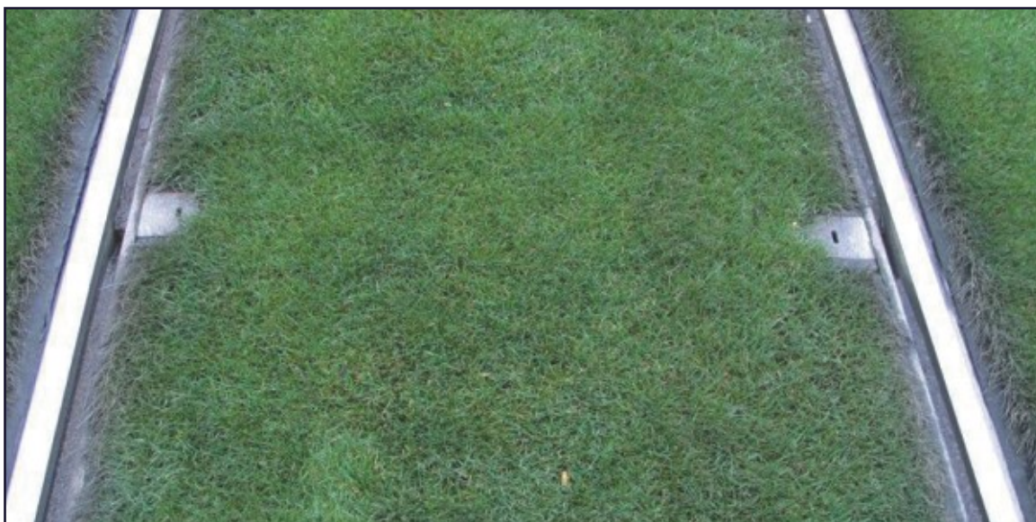
Řešení pro zatravněné úseky tramvajové trati
