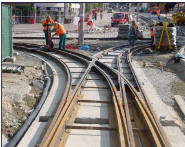
Dvourozchodné tramvajové křížení v městě Liberec
