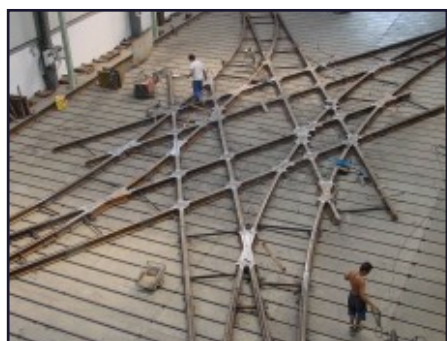
Kolejové křížení ve výrobní hale
